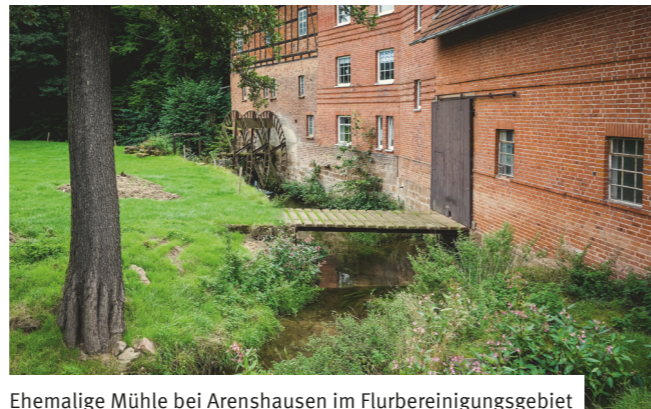
Ehemalige Mühle bei Arenshausen im Flurbereinigungsgebiet
