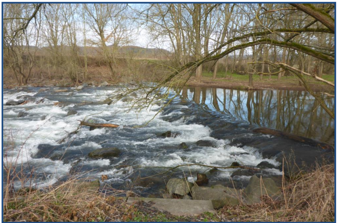
Rampe ehem. Hundeheimwehr, Ist-Zustand (Quelle: ThLG)
