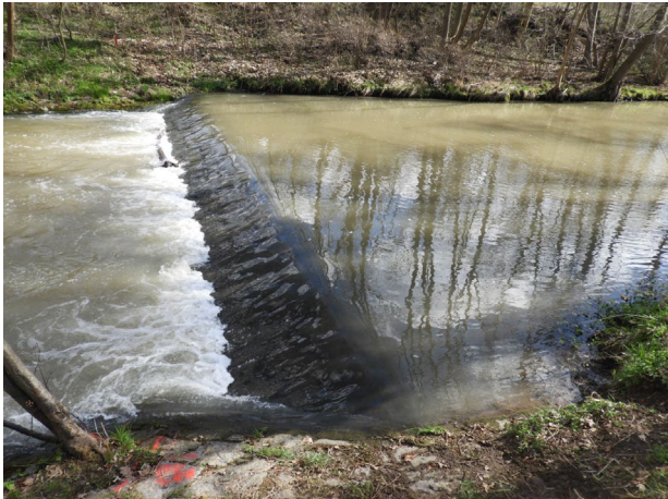
Bild 1: Ansicht des Sohlabsturzes zwischen Graben Schwabhausen und ehem. Furt (Quelle: ThLG)
