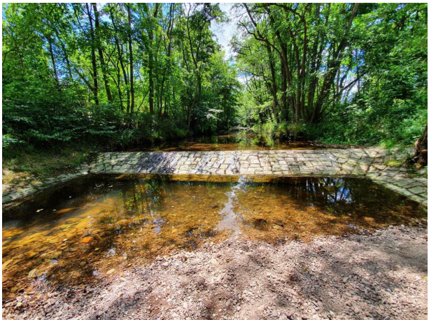
Bild 2: Sohlabsturz, Blickrichtung Schwabhausen, (Quelle: CundE)
