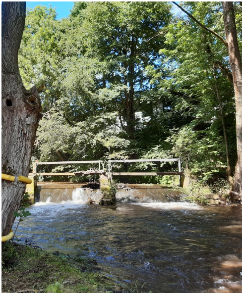
Bild 1: Ansicht des ehemaligen Querbauwerks IL60 (Quelle ThLG)
