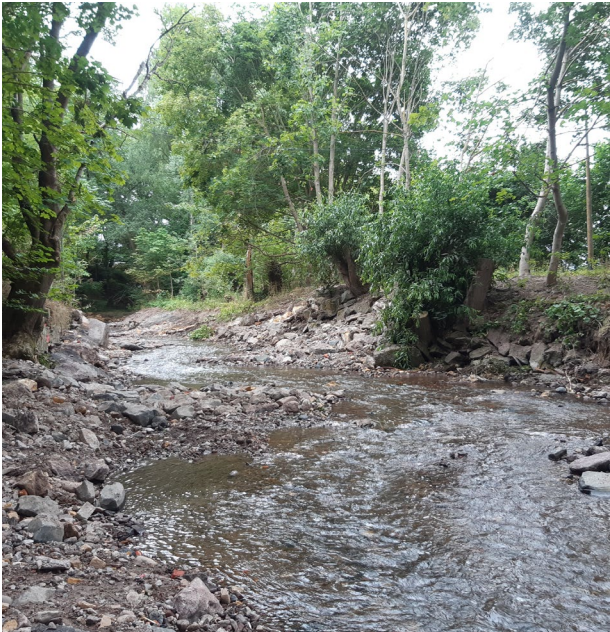
Bild 2: Ansicht fertige Sohlenstruktur IL54 (Quelle: ThLG)
