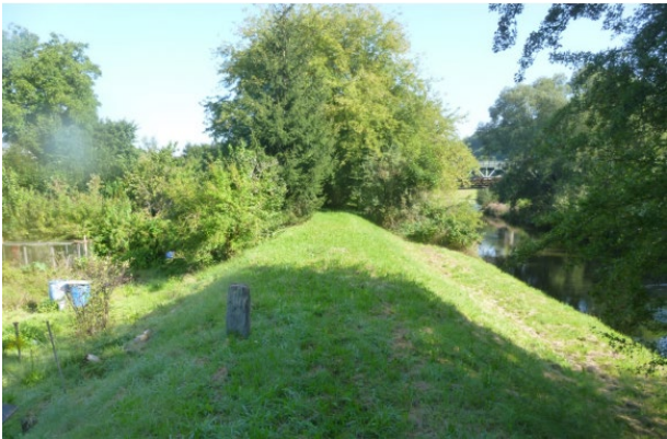
Bild 1: Deich zwischen DB-Brücke und Brücke Mylauer Straße vor der Maßnahmenumsetzung (Quelle: PGS, Hr. Schmeier)
