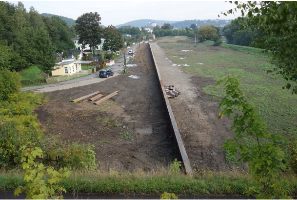
Bild 2: Mittelweg der Kleingartenanlage mit angrenzender Spundwand in rückverlegter Trasse (Quelle: ThLG, Hr. Herold)
