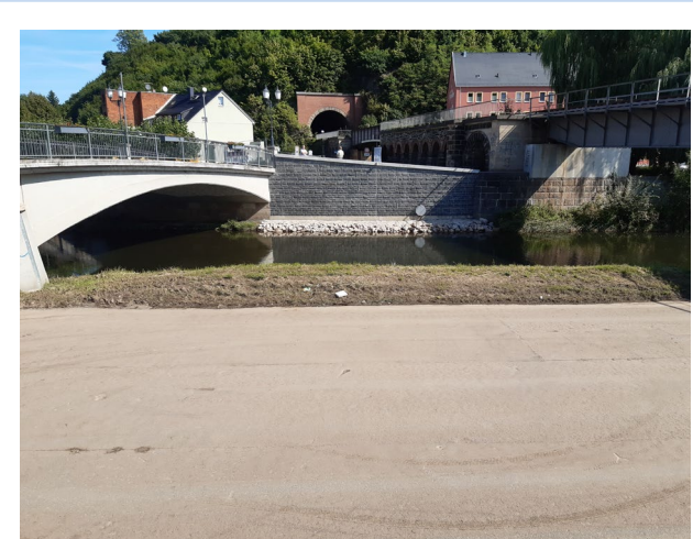
Ufermauer an der Bahnbrücke nach Fertigstellung der Maßnahme (Quelle: ThLG)
