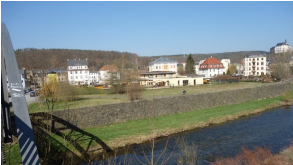
Bild 1: Die "Alte Schlossmauer" am linken Ufer der Weißen Elster unterhalb der Hainbergbrücke vor Baubeginn (Quelle: PGS, Hr. Schmeier)
