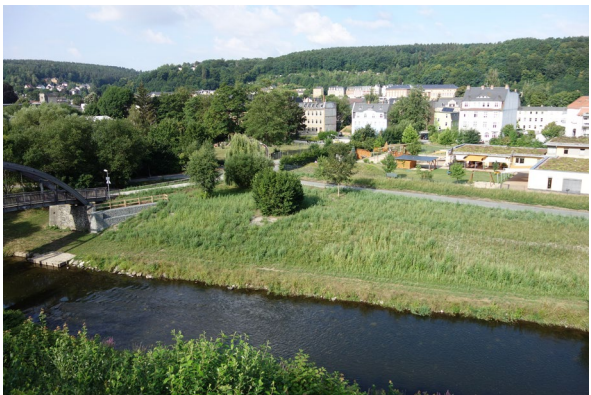
Bild 2: nach Rückbau der Bestandsanlage angelegtes Hochufer (Quelle: ThLG, Hr. Herold)
