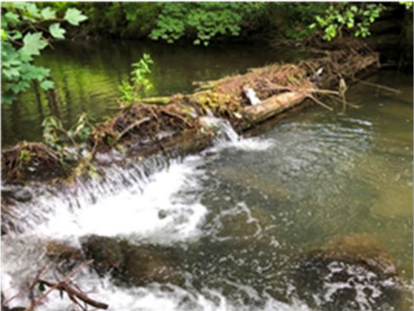
Bild 1: Holzschwellen mit Treibgutansammlung bei LO18 (Quelle: KUBENS, Hr. Deutschmann)
