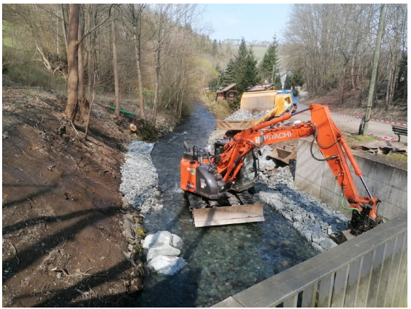
Bild 2: Böschungssicherungsarbeiten im Bereich LO26 (Quelle: ThLG, Hr. Herold)
