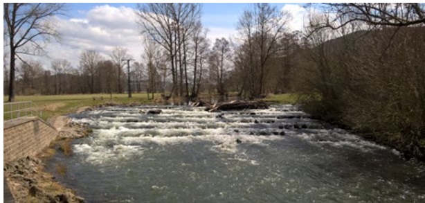
Bild 1: Ansicht der ehemaligen Sohlengleite mit Querriegeln in Belrieth (Quelle: ThLG)
