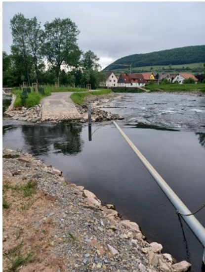
Bild 2: Neue Sohlengleite mit 13 Querriegeln, links: Einlauf zum Mühlgraben mit Schwimmbalken und Gewässereinfahrt (Quelle: ThLG)
