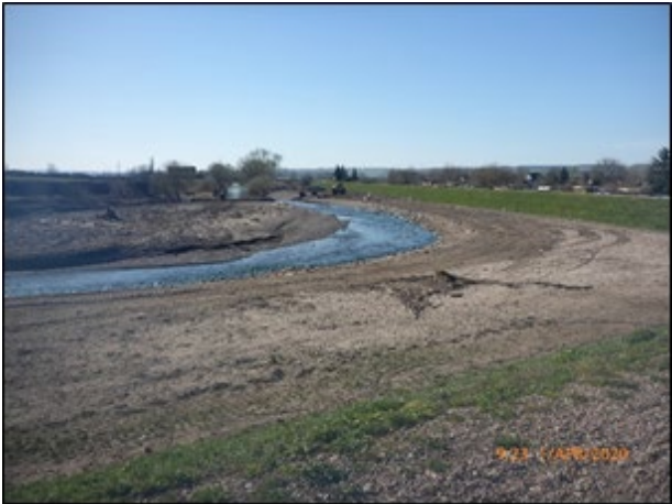
Deichrückverlegung und Gewässerstrukturierung bei Walsleben, 04/2020 (Quelle: Y.Voigt, ThLG)
