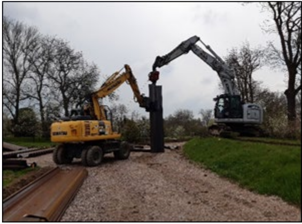
Ertüchtigung Deich bei Ringleben, 04/2022 (Quelle: S.Olbrich, ThLG)
