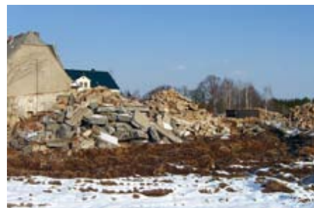
Vorher: Abriss der Gebäude Februar 2013
