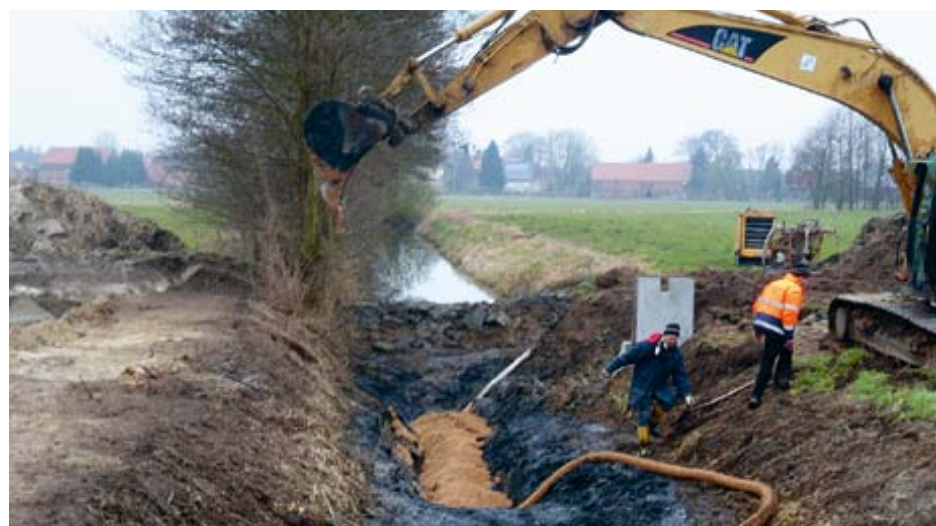
Baggerarbeiten für die Fischaufstiegstreppe (Sohlgleite mit Bypass) an der Tarnitz bei Muchow
