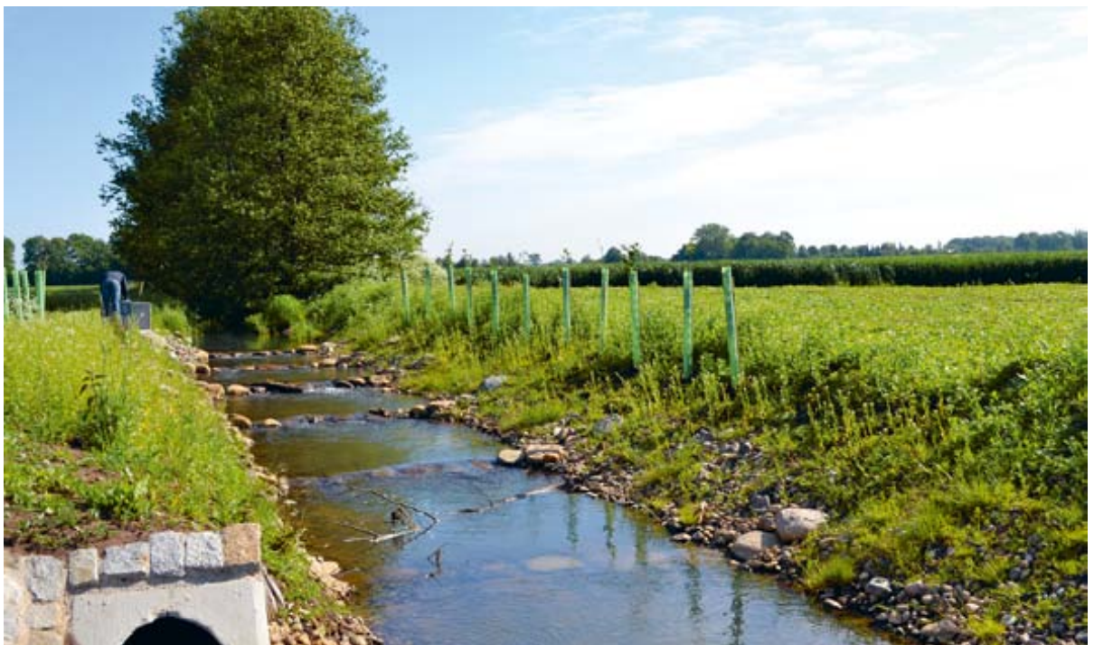
Die fertiggestellte Fischaufstiegstreppe zwischen Muchow und Zierzow mit dem Überlaufwerk (Bypass links)
