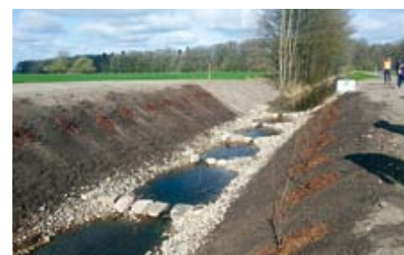
Bauabnahme der Fischaufstiegstreppe im Frühjahr 2015
