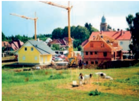
Wohnbaustandort Mühlhausen-Pfafferode (Foto: ThLG; 2004)
