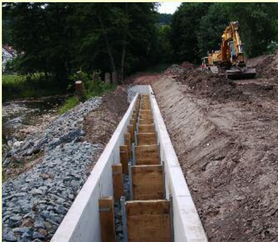
Wehr F02/03 in Dietlas „Technischer Fischpass im Bauzustand“
