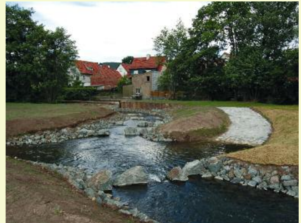
Wehr F10 in Weilar „Naturnahes Umgehungsgerinne mit Beckenstruktur“
