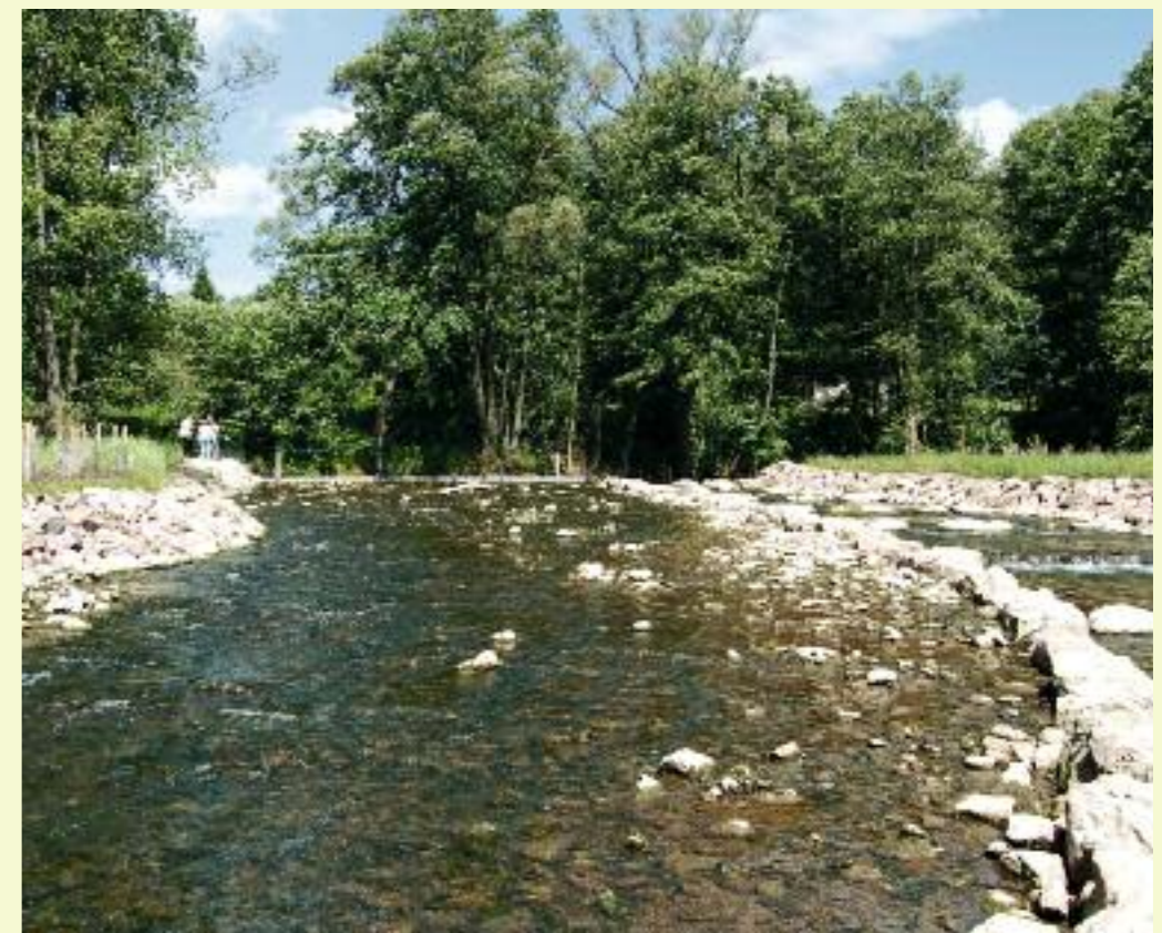
Wehr F07 in Stadtlengsfeld „Sohlgleite mit Beckenstruktur“
