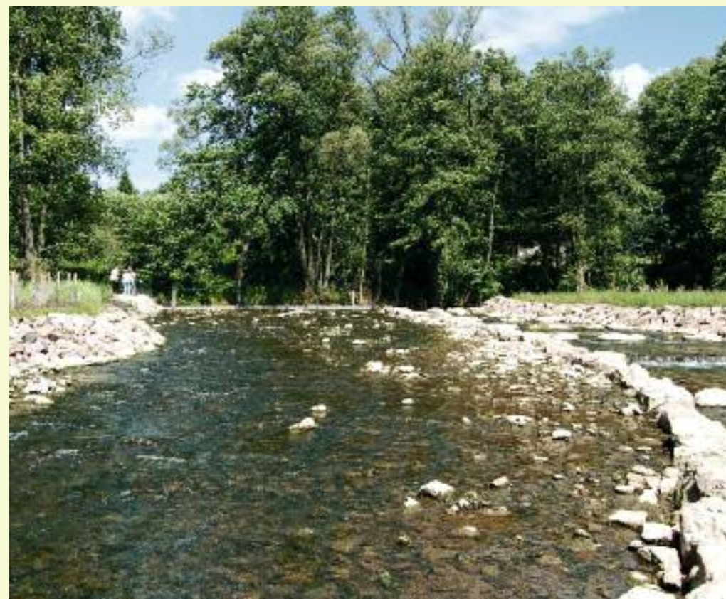
Wehr F07 in Stadtlengsfeld „Sohlgleite mit Beckenstruktur“
