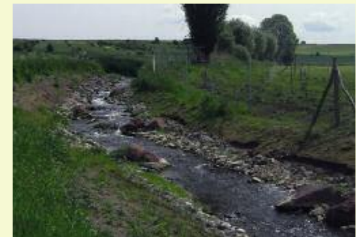
Durch die gezielte Lenkung der Eingriffsregelung ersetzt nun eine - für Wasserorganismen durchlässige - Sohlgleite das alte Mühlenwehr
