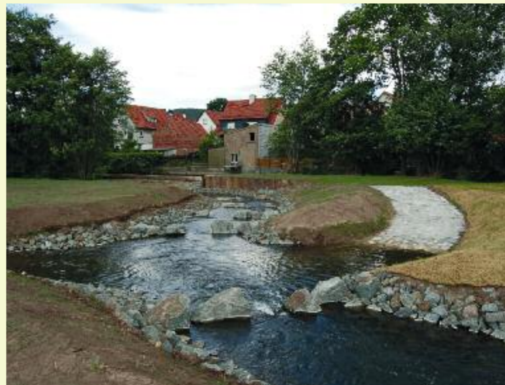
Wehr F10 in Weilar „Naturnahes Umgehungsgerinne mit Beckenstruktur“
