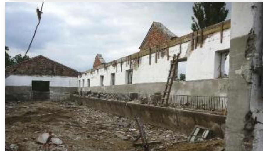
Künftig besteht eine Prüfpflicht, ob der Ausgleich oder Ersatz vorrangig auch durch Maßnahmen zur Entsiegelung, durch Maßnahmen zur Wiedervernetzung von Lebensräumen oder durch Bewirtschaftungs- oder Pflegemaßnahmen erbracht werden kann. Damit soll möglichst vermieden werden, dass Flächen aus der Nutzung genommen werden
