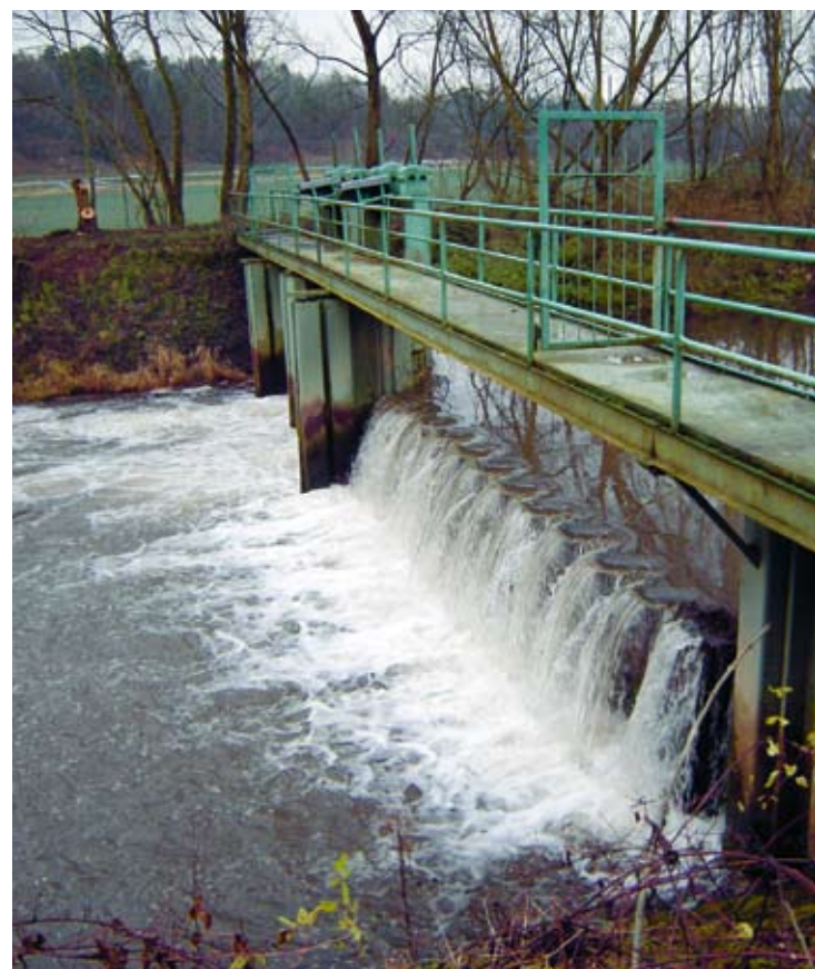
Notwendigkeit einer Maßnahme zur Durchgängigkeit (OWK Leine)
