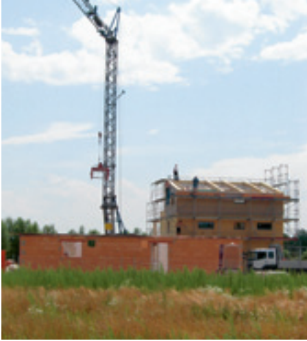
Im Hintergrund das erste Passivhaus – aus Fertigteilen über Nacht aufgestellt
