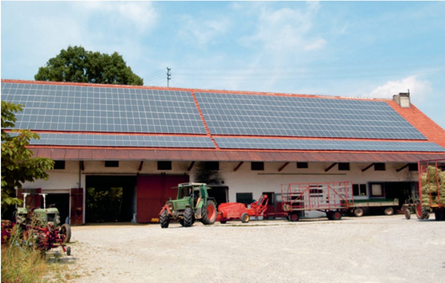
Viele Dachflächen landwirtschaftlicher Gebäude bieten Potenzial zur Energieerzeugung.
