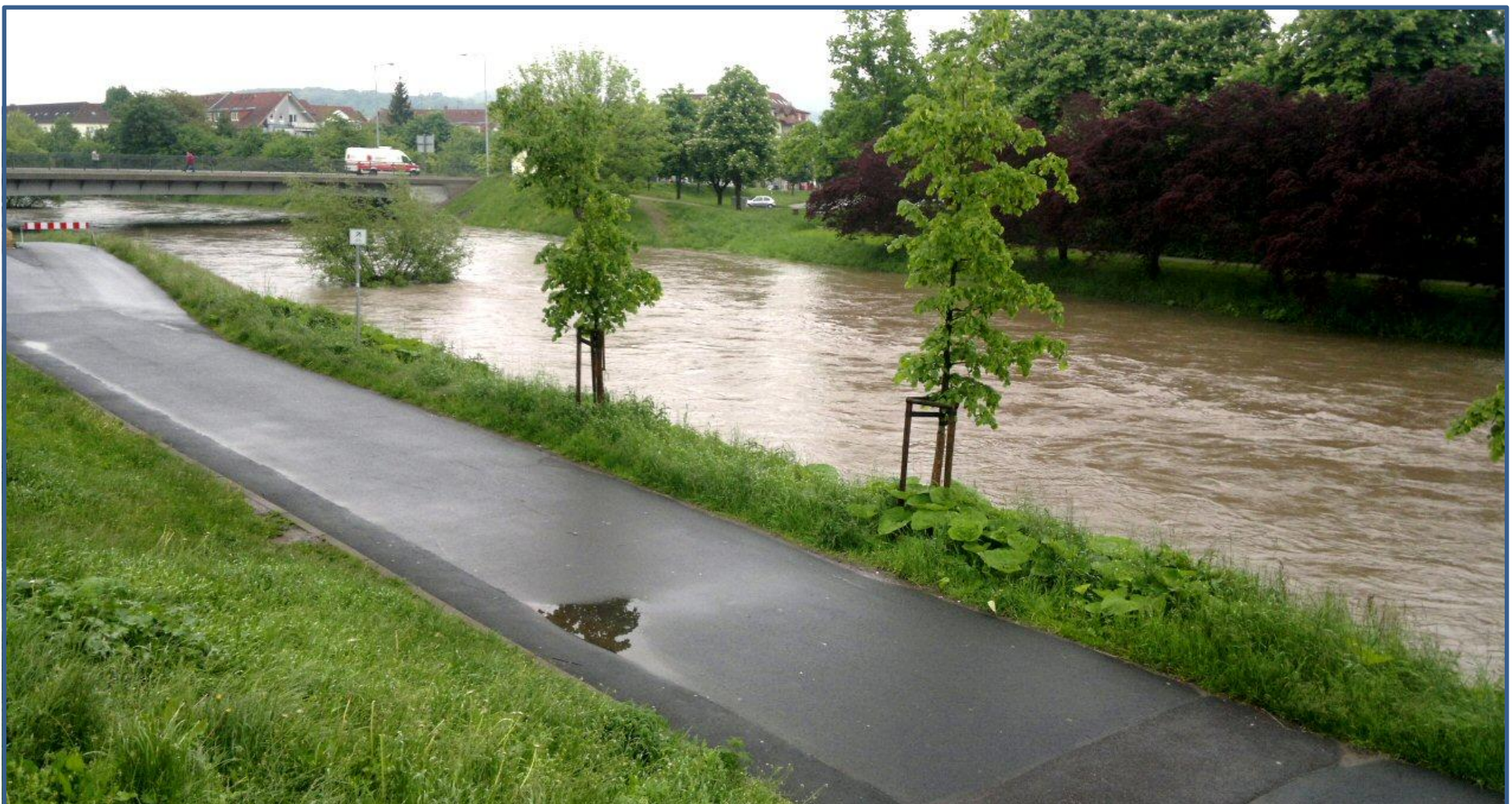
Quelle: TLUG Das Hochwasserereignis von 2013 an der Hörsel in Eisenach in Höhe der Brücke Mühlhäuser Straße
