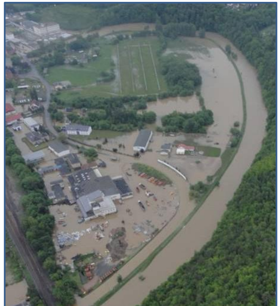
Ist-Zustand, Quelle: IB Lopp Planungsgesellschaft mbH
