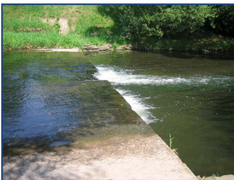
Sohlabsturz ehem. Schlachthofsteg. Bestand
