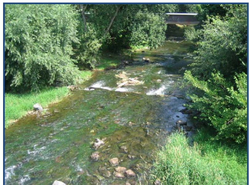
Sohlabsturz Erfurter Brücke. Bestand
