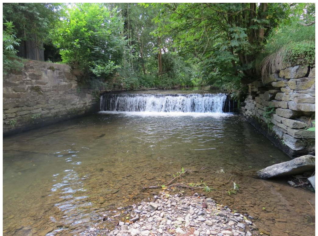
LO16 Querbauwerk, Absturz aus Sicht Unterwasser (Blickrichtung Südwest) Quelle: IB Kubens
