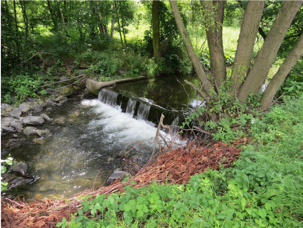
LO12 Querbauwerk, Ansicht Absturz von linker Uferseite (Blickrichtung Süd-Südost) Quelle: IB Kubens
