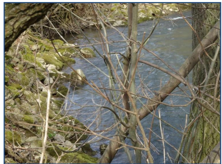
Abb.2: Steinschüttung zur Böschungssicherung
