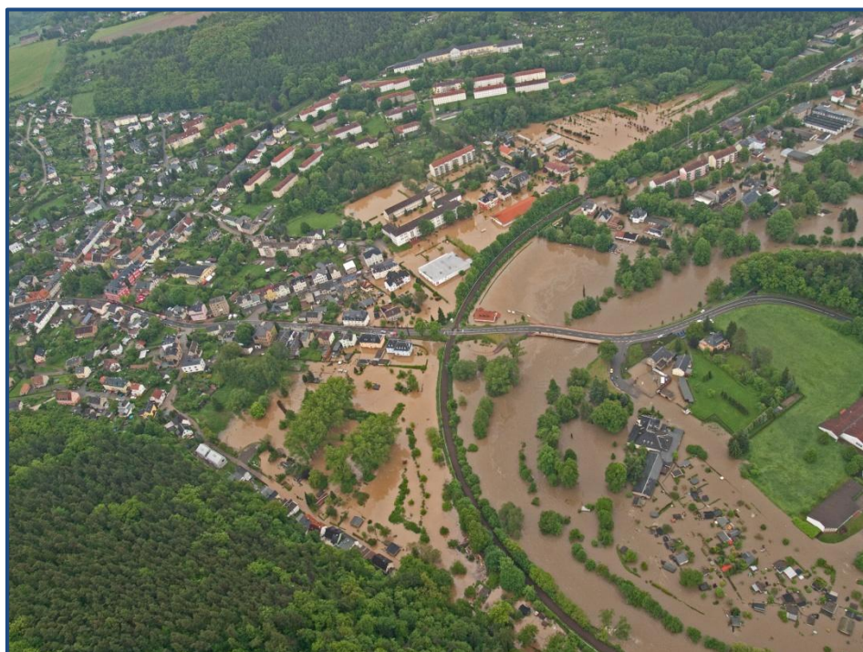
Überflutung der Ortslage Berga/Elster, 2013
