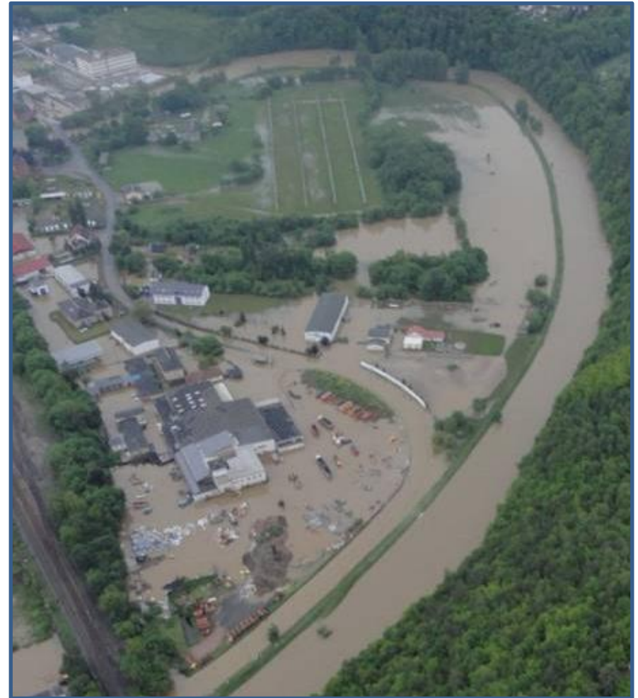
Ist-Zustand, Quelle: IB Lopp Planungsgesellschaft mbH
