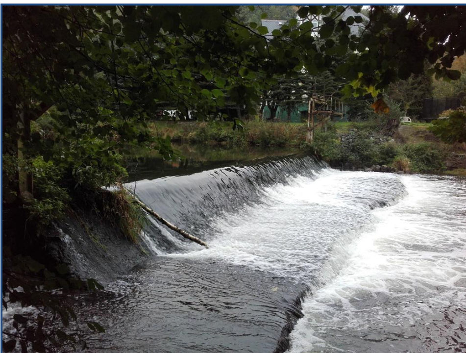
zurückzubauendes Wehr in Greiz-Rothenthal zur Herstellung der ökologischen Durchgängigkeit
