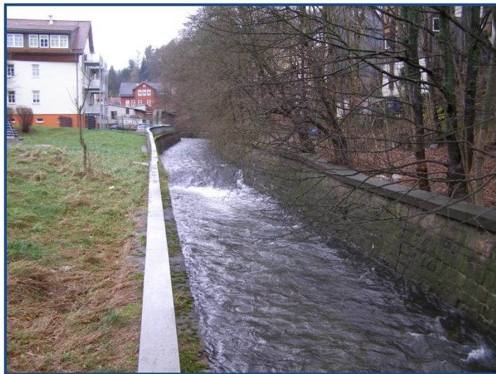
technisch ausgebauter Gewässerabschnitt der Lauter in der Ortslage Suhl
