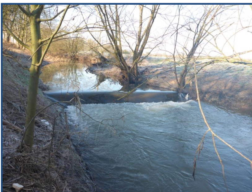
Sohlenabsturz HM 16 (Blick aus dem Unterwasser)
